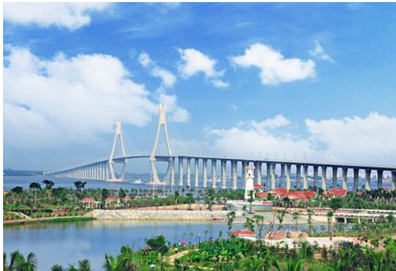
湛江海湾大桥
